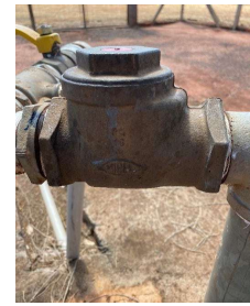
Figura 18 - Válvula de retenção
