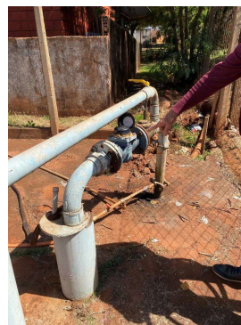
Figura 1 – Afloramento do poço
