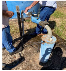
Figura 28 - Dispositivo: Laje de proteção sanitária e tubo medidor de nível.
