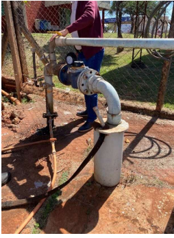
Figura 4 - Dispositivos: laje de proteção sanitária e tubo para medição de nível.
