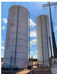
Figura 23 – Vista Geral R1 e R2
