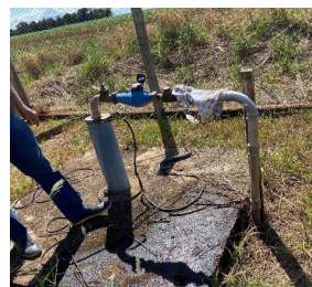
Figura 25 - Vista Geral do Poço P04
