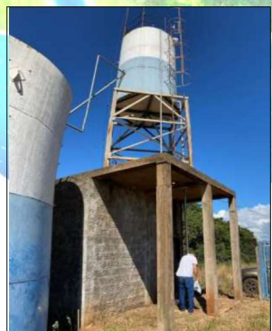
Figura 44 – Vista Geral - Reservatório 4
