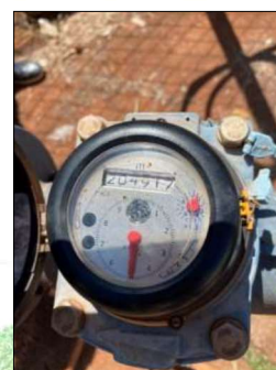
Figura 17 - Destaca-se o macromedidor com totalizador de volumes captados. Fonte: Prefeitura Municipal, 2023.
