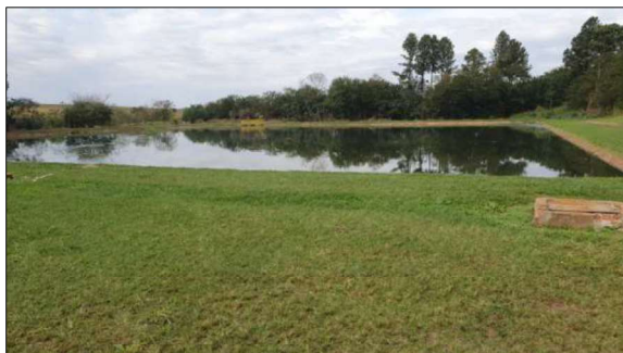
Figura 52 – ETE – Lagoa Facultativa Fonte: Prefeitura Municipal
