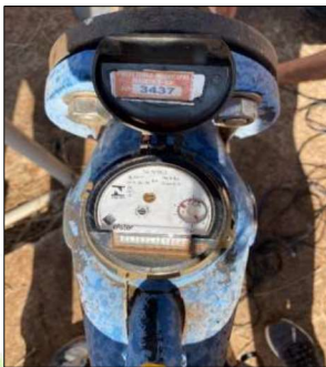
Figura 31 – Medidor destacando-se o totalizador de volumes captados. Fonte: Prefeitura Municipal, 2023.
