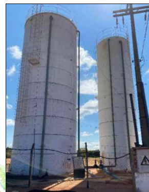
Figura 42 – Vista Geral - Reservatório 1 e Reservatório 2
