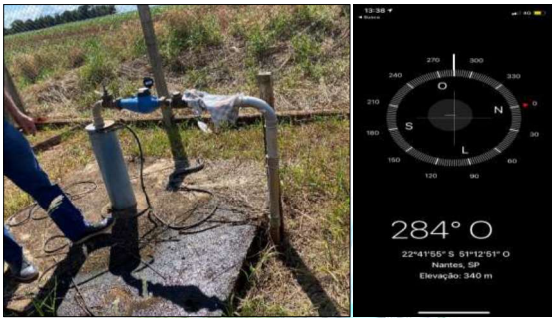
Figura 34 – Aforamento do poço e localização.
