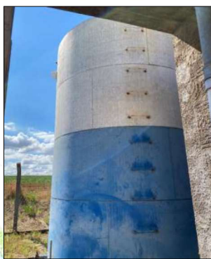
Figura 43 – Vista Geral - Reservatório 3
