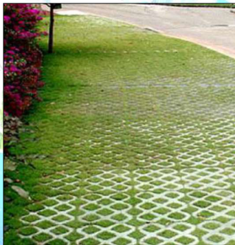
Figura 74 – Exemplo de aplicação de pavimento poroso (Concregrama)
