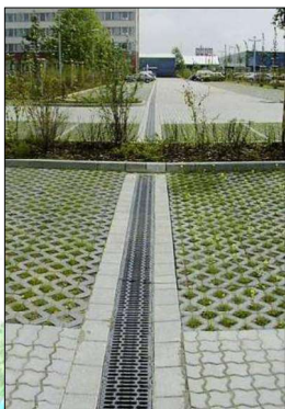
Figura 75 – Aplicação de trincheira de infiltração em passeios
