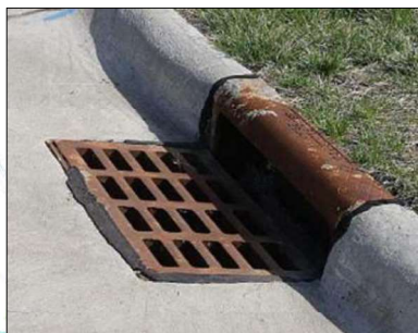
Figura 72 – Gradeamento em boca de lobo na sarjeta
